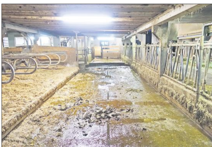
Der alte Laufgang mit Urinpützen. Die sind der Klauengesundheit abträglich.
