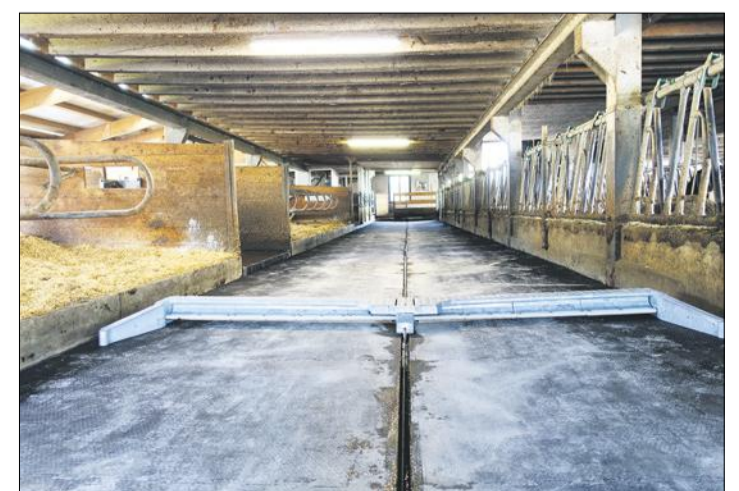
Die neuen Matten im Laufgang. Ersetzt wurde auch der Schieber, der bereits ziemlich abgeschliffen war.
