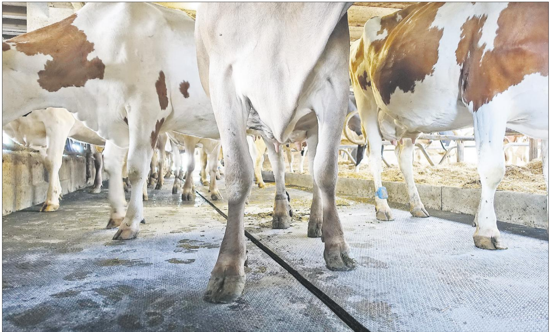
Die Kühe des Gutsbetriebes Hohenrain geniessen den neuen rutschfesteren Gummibelag auf dem Laufgang im Stall.
